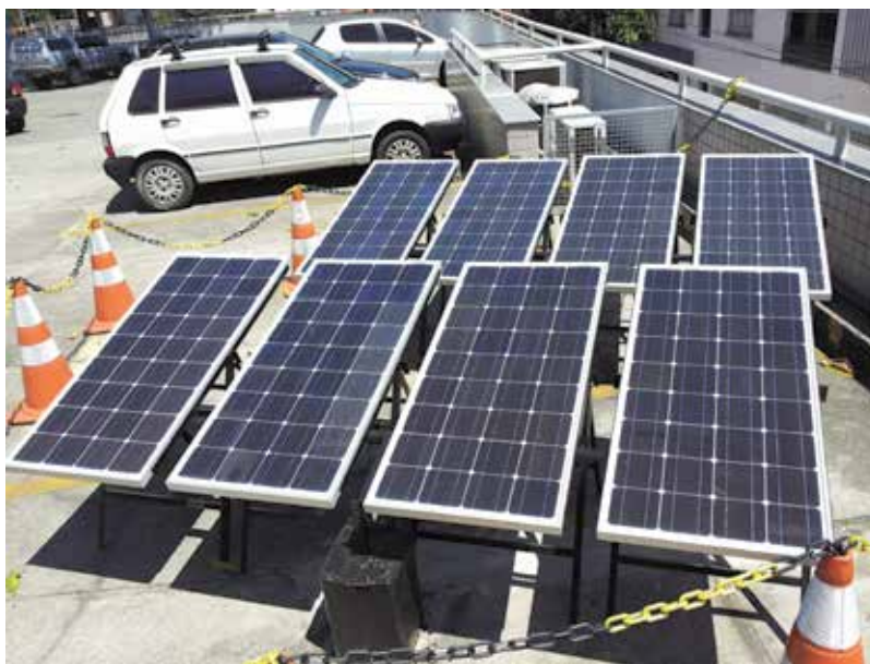
Figura 1 – Instalação dos geradores fotovoltaicos sobre suportes metálicos
